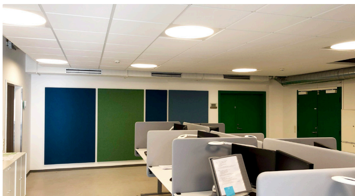
Systemloft og TYST paneler på væggene
