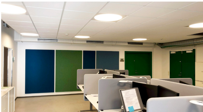
Systemloft og TYST paneler på væggene
