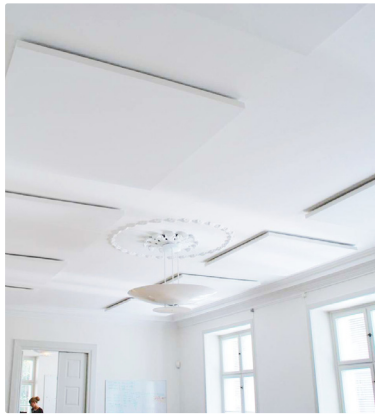
ALPHA SOLO med tæt-på beslag i loftet
